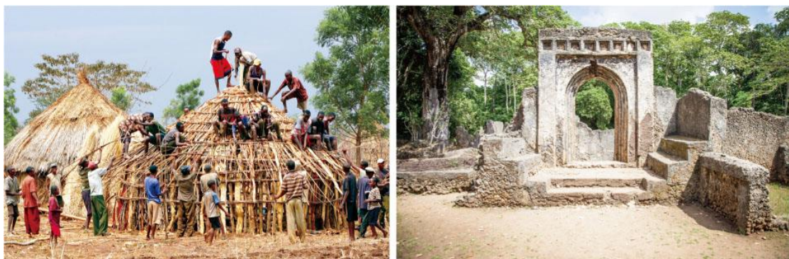
▲圖 3-14 東非沿海地區的傳統建築。早期多就地取材以土石、樹枝等搭蓋（左），而伊斯蘭文化傳入後，風格漸趨多樣化，主要建材多利用海邊的石材（右）。
