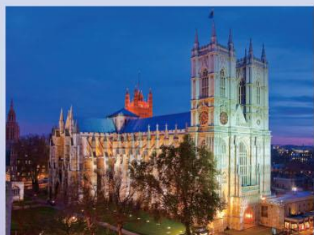
▲圖 7-37 倫敦西敏寺 (Westminster Abbey)。典型哥德式建築結構，建築風格呈現尖塔、尖型拱門與飛扶壁，玻璃花窗則營造華美神祕的氣氛。
