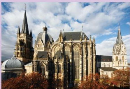
▲圖 7-36 德國亞琛大教堂 (Aachener Dom)。羅曼式建築除延續羅馬式拱型特色外，開始增加高塔、尖塔風格。
