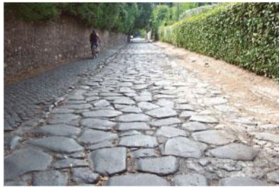
▲圖 6-35 羅馬的道路。以羅馬為中心，連結各地四通八達，而有「條條道路通羅馬」之稱。路面鋪以平整的石塊。路面中間稍微隆起，以利排水。道路兩旁除有排水溝，還砌石保護路基，因此可以經久耐用，至今仍能看到遺跡。
