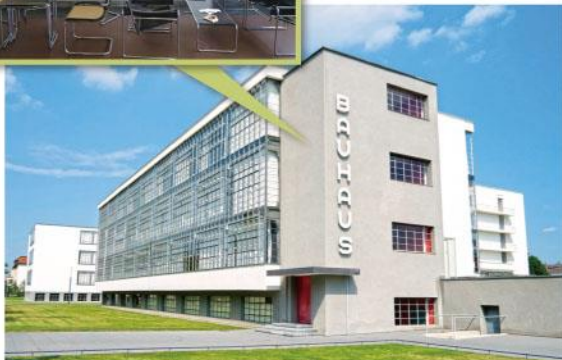
▲圖 9-18 包浩斯 (Bauhaus) 學院。該校大樓展現明亮玻璃帷幕、乾淨通透的室內設計及水平屋頂等現代主義建築特色，校內也採用實用的鋼管椅，在當時為一創舉。
