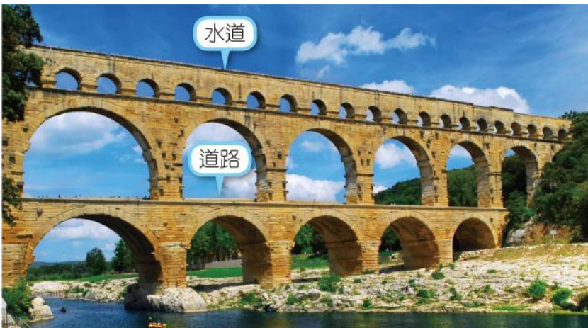
◀圖 6-36 加爾橋(Pontdu Gard)。位於法國南部。為使供水系統通過加爾河，羅馬工程師設計了上下三層，高達 49 公尺的連拱橋梁。橋梁最上層是封閉的水道，中、下層用做橋體支撐與道路。這座橋樑歷兩千年的歲月而不搖，表現了羅馬美學與科學工藝的成就。
