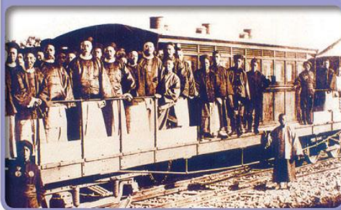
▲圖 11-9 （1881）李鴻章等人視察開平礦務局築成的唐胥鐵路。唐胥鐵路是中國第一條自建鐵路。
