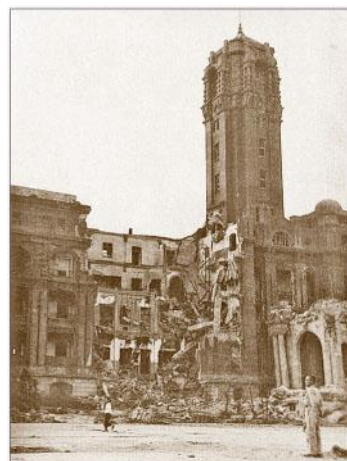
▲圖 8-21 轟炸臺灣總督府。雖然日本軍方將總督府百般偽裝及防範,最後還是遭到美軍轟炸命中,導致部分建築物損壞。
